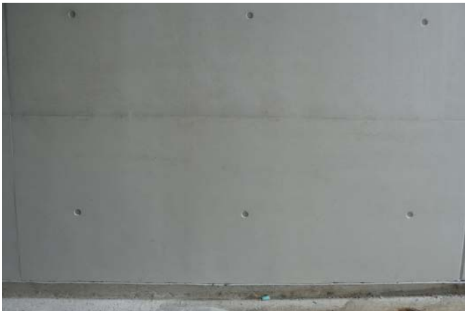
Sichtbetonflächen nach der Restaurierung
